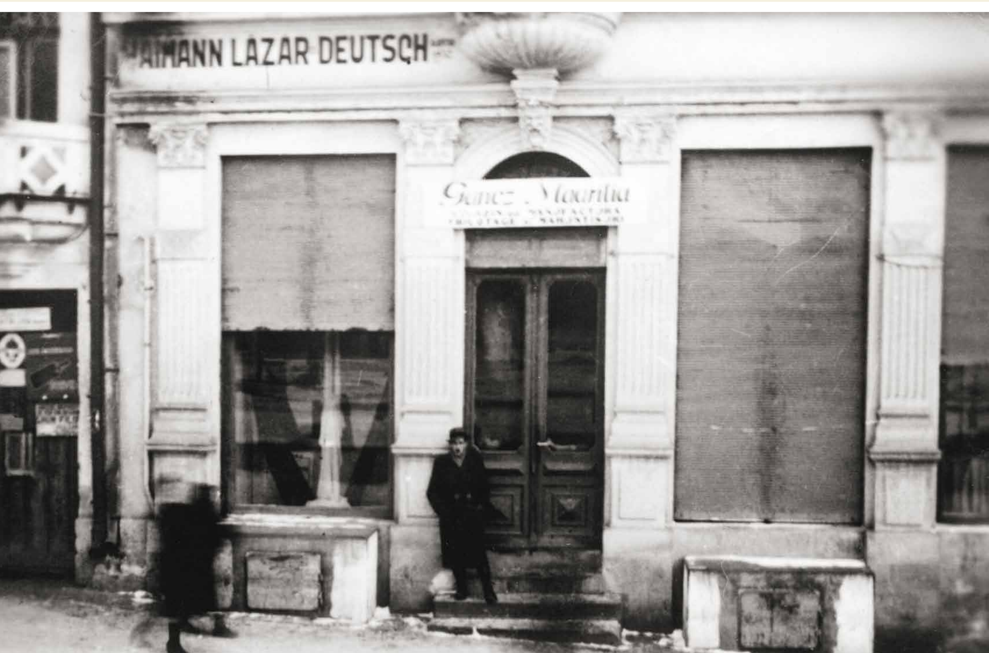
Das ist das Kleidungsgeschäft in Reghin in den 1930er Jahren. Das Gebäude ist heute das Gericht von Szaszregen.
